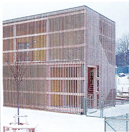
Ett andra skal kan användas som gestaltning men också för att hantera solavskärmning, skapa en skyddad plats för vila utomhus samt för att täcka in utrymningstrappor, soprum och ventilationsgaller.
