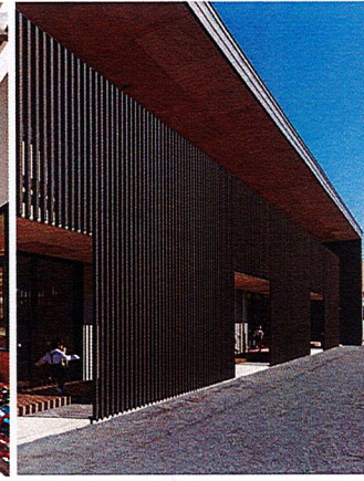
Ett andra skal kan användas som gestaltning men också för att hantera solavskärmning, skapa en skyddad plats för vila utomhus samt för att täcka in utrymningstrappor, soprum och ventilationsgaller.
