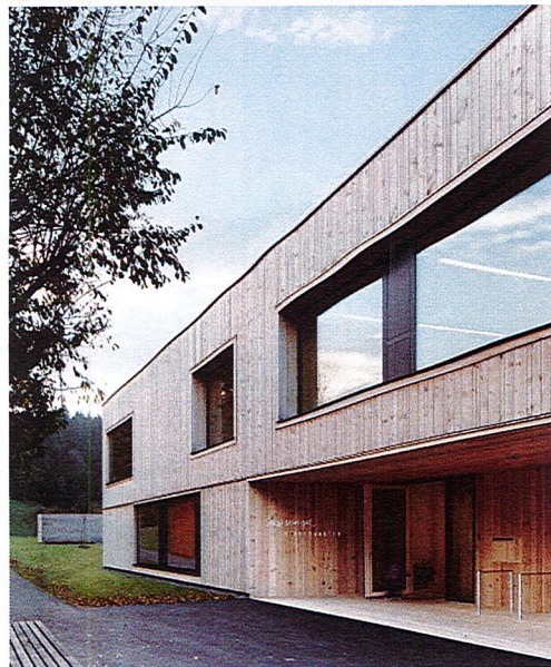
Träfasad för att anpassa sig till omgivande byggnader och koppla an till naturen och skogen. Värmebehandlad, svart slamfärg, eller röd. Kontrastgivande detaljer med fönster.
